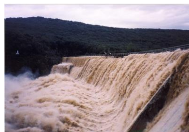
Figure 1 : Surverse du barrage de la Rouvière (Gard) lors de la crue de 2002.
